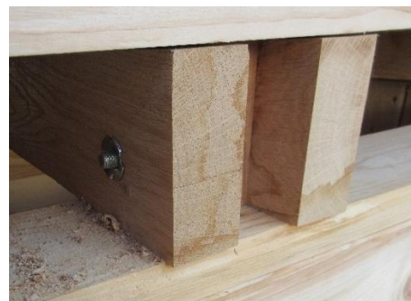
Verschraubung Stützen/Schwelle
